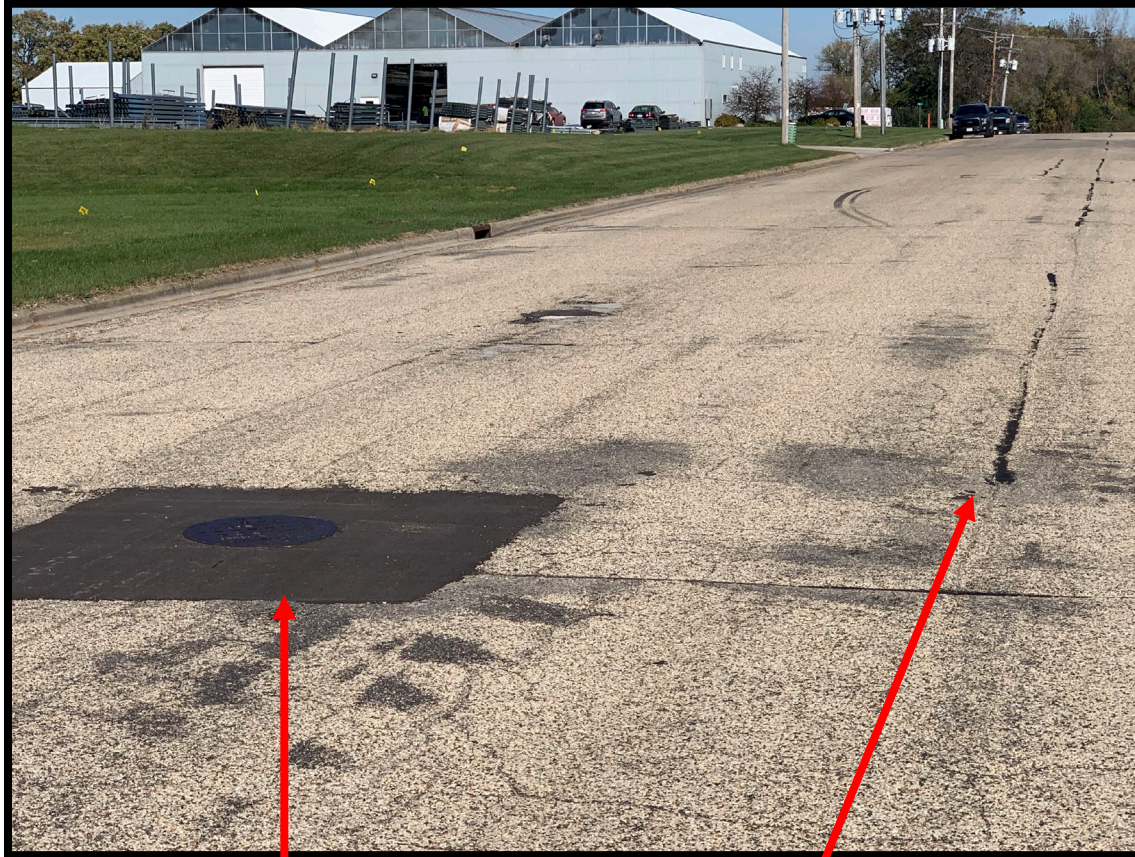
Longitudinal Cracking
